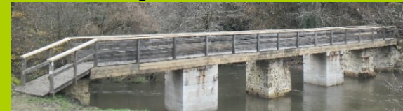
Passerelle de Sauvaget
